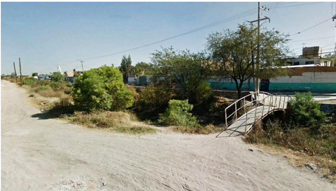
Condiciones de la infraestructura peatonal en las calles de San Luis Rey y La Trinidad
