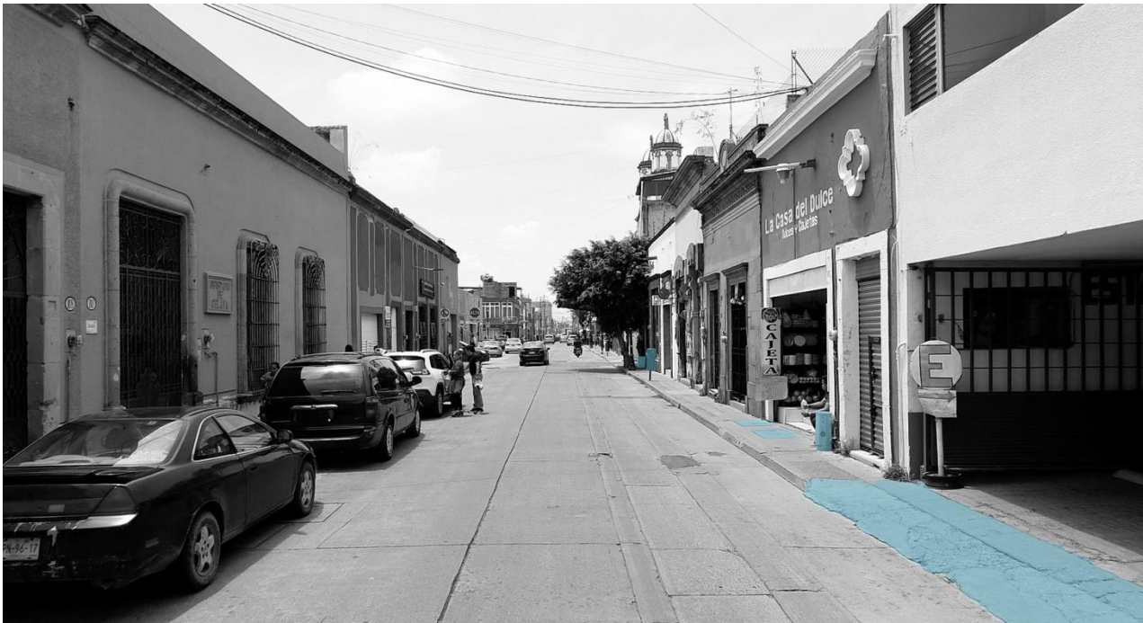
BANQUETAS CALLE MANUEL DOBLADO Reducción de amplitud de banqueta por mobiliario urbano (medidores y basureros), cambios de niveles en pavimentos por registros eléctricos. Rampas vehiculares que dificultan el tránsito peatonal. Banquetas con parches y en malas condiciones.
